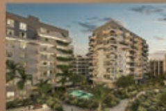
WeLive Casa Anfa
